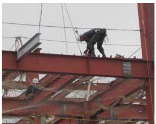
安全帯は必要な人だけが付ける。どんな作業でも安全帯を付けさせておくのは、むしろ危険を招く。(写真提供：中村秀樹)
