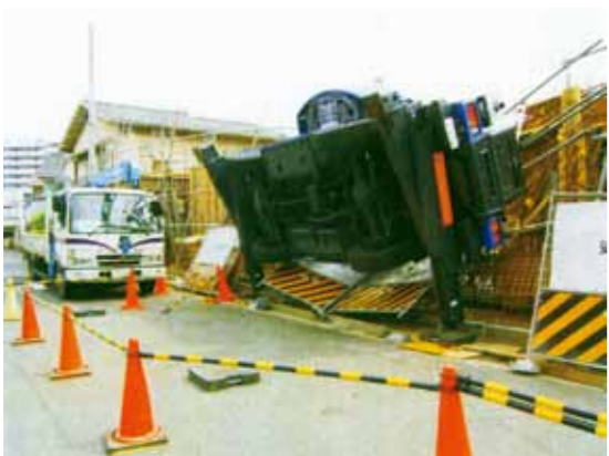
重機による事故は後を絶たない。写真は、個人住宅の建築工事において、トラックの荷台から12トンホイールクレーンで型枠材を現場内過負荷防止装置を無効に搬入する作業中、定格荷重を超える単管(重量約980キロ)を吊り上げたため、ホイールクレーンが転倒したものの。(写真提供：片寄茂夫)
